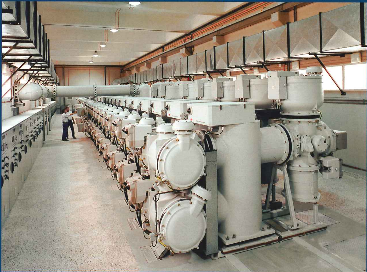
カタール・ドーハに設置されたGIS(ガス絶縁スイッチギア) / 写真提供: ABB
