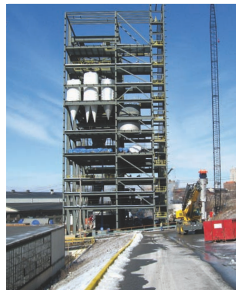
Вид на северную сторону строящегося здания котельной
