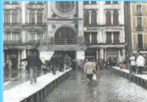
Flooding of the Piazzo San Marco.
